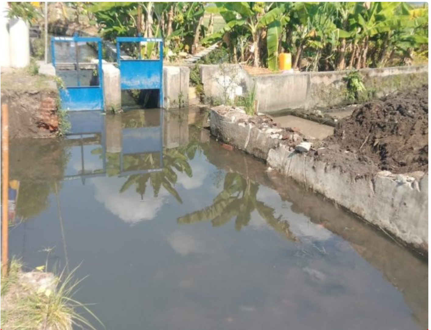
Inilah Lokasi Jembatan Yang Akan Di Buat Satgas TMMMD Reg 121
